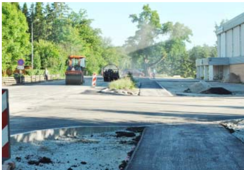
Asfaltteerimistööd Vinni spordikompleksi ees. Foto: Hilje Pakkanen
