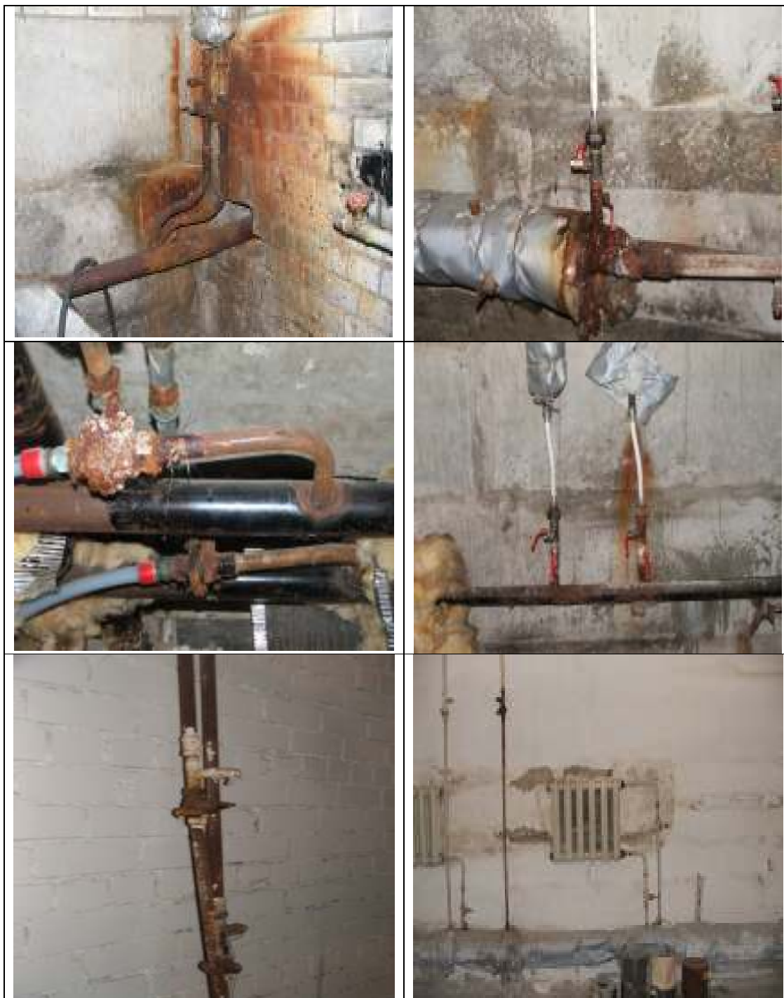
Pilt 6. Koolimaja küttesüsteemi magistraalitorude ja püstikute ühenduste tüüpiline seisukord
