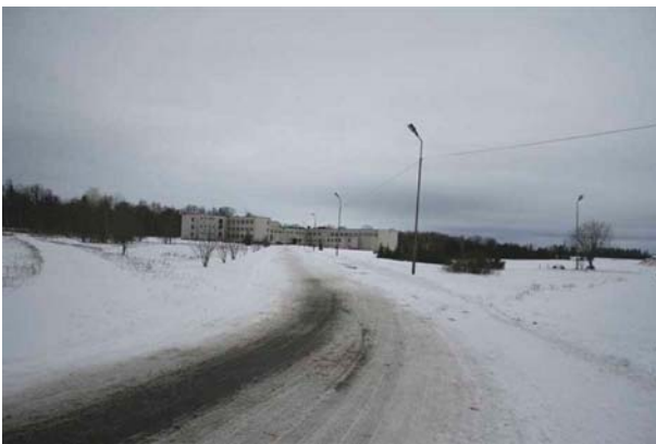
Pilt 2. Liiga suur kaldenurk
